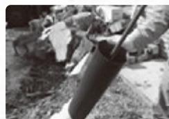
運び出した煙突は各ピースに分解し、ワイヤークリーナーで掃除します。
