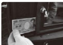
お札などの紙を挟んで、ドアを閉めます。お札が挟まらずに抜けるようだったらノブが緩みすぎなので調整します。
