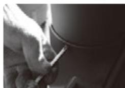
ストーブ本体と煙突を接続しているビスを外します。
