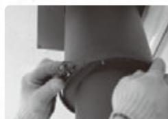
シングル煙突から2重断熱煙突に変わる接続(アダプター)を外すためロッキングバンドを外します。
