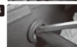
外側の取手との接続部を外す。押さえ金具(エリング)は、マイナス・ドライバーなどの先を使い、テコの原理で外します。
