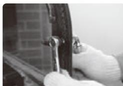
ドアノブの調整は裏側のボルトを閉めて行います。レンチでボルトの締め付けをします。
