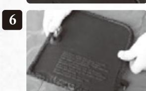
最後にハサミなどでガスケットを切って、はみ出ないように納めて完了です。
